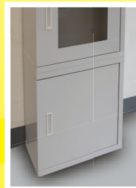
土台を外して背面を壁面に固定
